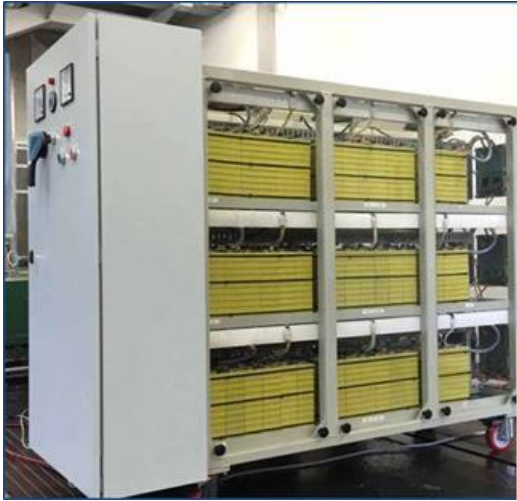
Pacco Batteria LiFePO 4
